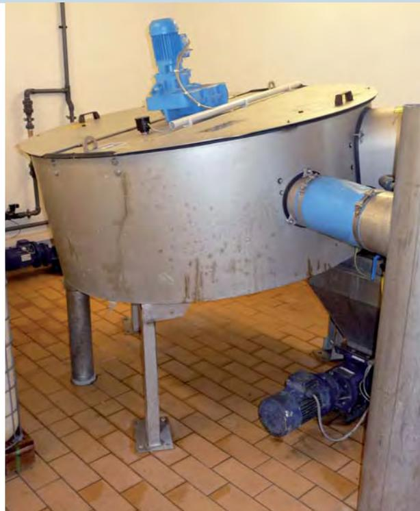
Bild 4.12: Maschinelle Eindickung auf der KA Bobitz
