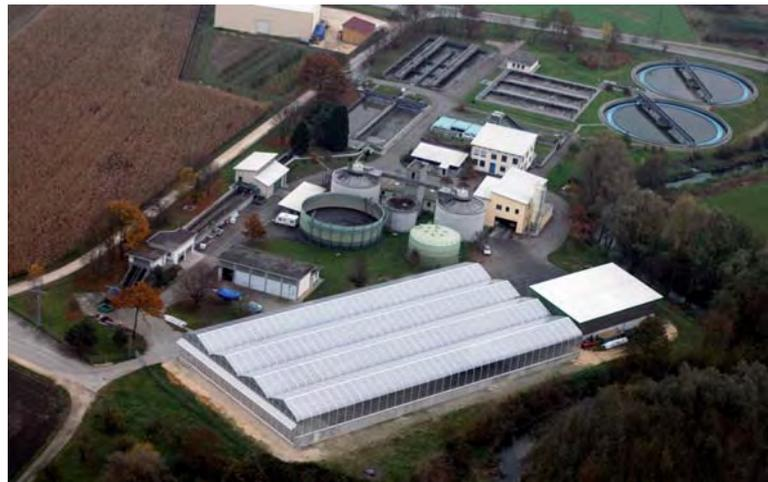
Bild 5.6: Solare Klärschlamm-trocknung KA Stockach, 50.000 EW
