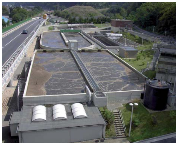
Kläranlage Bad Ems
