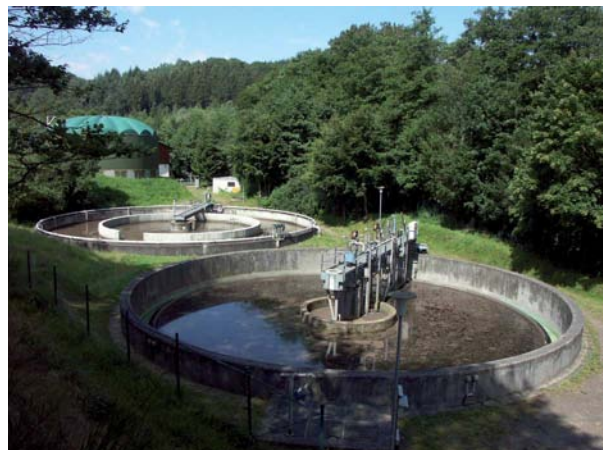
Kläranlage Oberes Fischbachtal
